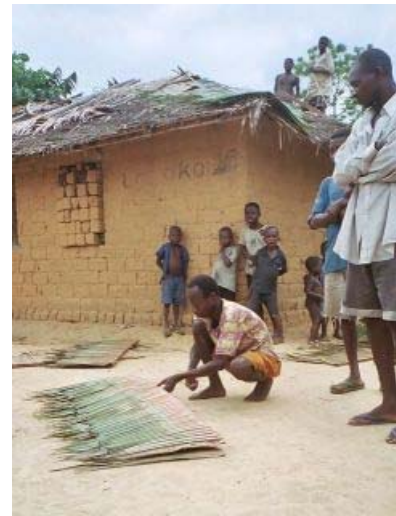
Figure 3. Utilisation de palmes pour recouvrir le toit d'une case. (Photo de Rick Alexander)
